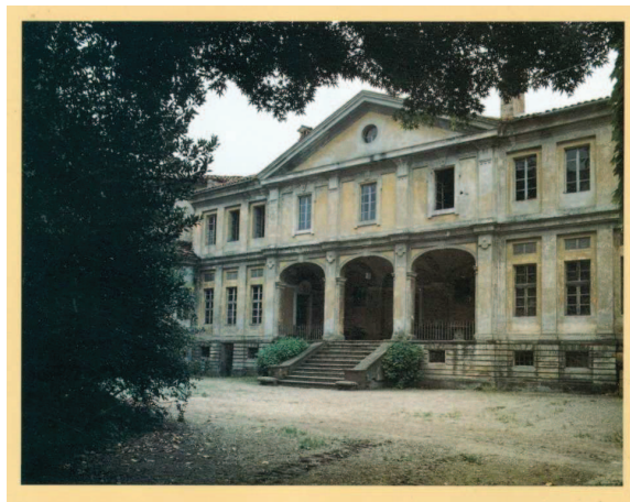
Facciata del castello di san Sebastiano da Po
